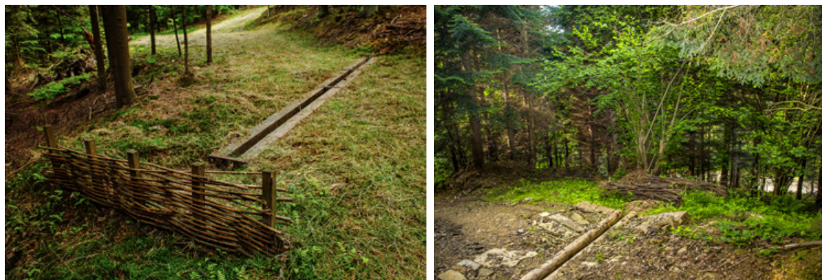
Fot. 134. i Fot. 135. Płotki faszynowe przeciwerozryne rozpraszające wodę na stok, Nadleśnictwo Gromnik (archiwum CKPŚ), Nadleśnictwo Łosie (archiwum CKPŚ)
